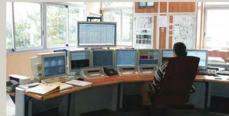
L'ensemble des opérations est programmé, piloté et surveillé 24h/24 depuis un centre de téléconduite installé dans le centre d'exploitation de Villette de Vienne. Cette salle de contrôle reçoit en permanence des informations en provenance des lignes, des stations de pompage, des vannes de sectionnement et des terminaux de livraison. En retour, des ordres sont émis pour réguler le transport des produits entre les lieux d'expédition et les dépôts pétroliers.
