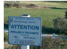
Le tracé du pipeline est matérialisé en surface par des balises. L'implantation des balises est réalisée à proximité du pipeline mais ne permet en aucun cas de le situer de façon exacte.
