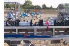
Ces raclers sont munis de capteurs qui permettent de contrôler l'état des parois des tubes.
