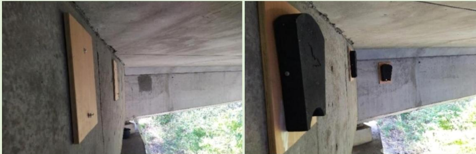
Gîte chiroptère de façade – exemple pose sans perçage
