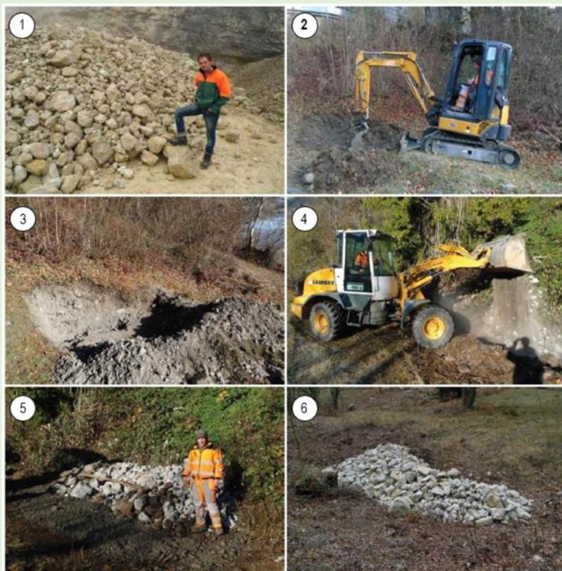
Étapes de réalisation d'un « tas de pierres » pour les reptiles
